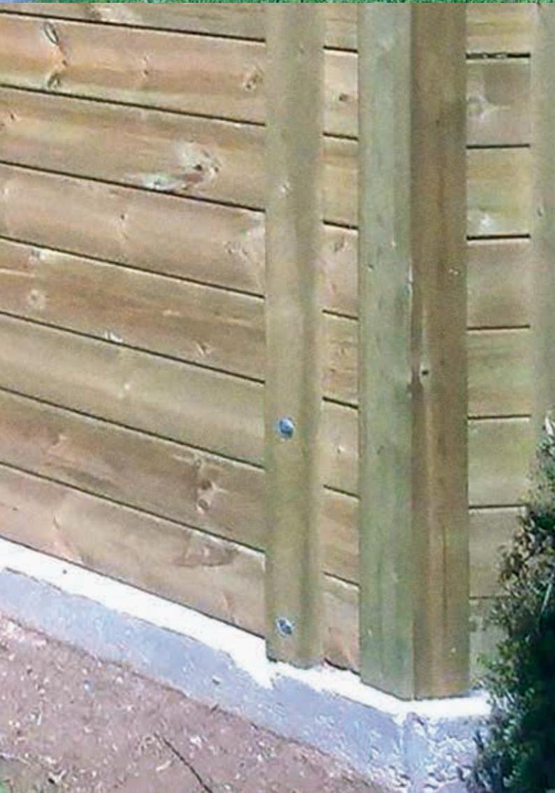
RÉALISATION Clôture Épicéa Préserve
